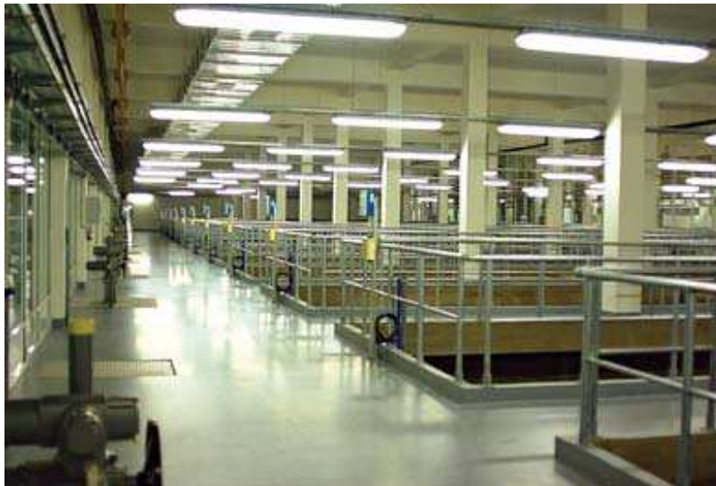
圖二 西部淨水場臭氧-吸附作業廠房的沉澱槽
