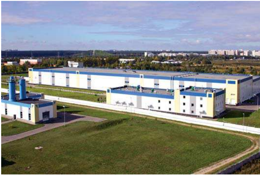
圖一 西部淨水廠的臭氧-吸附作業廠房
