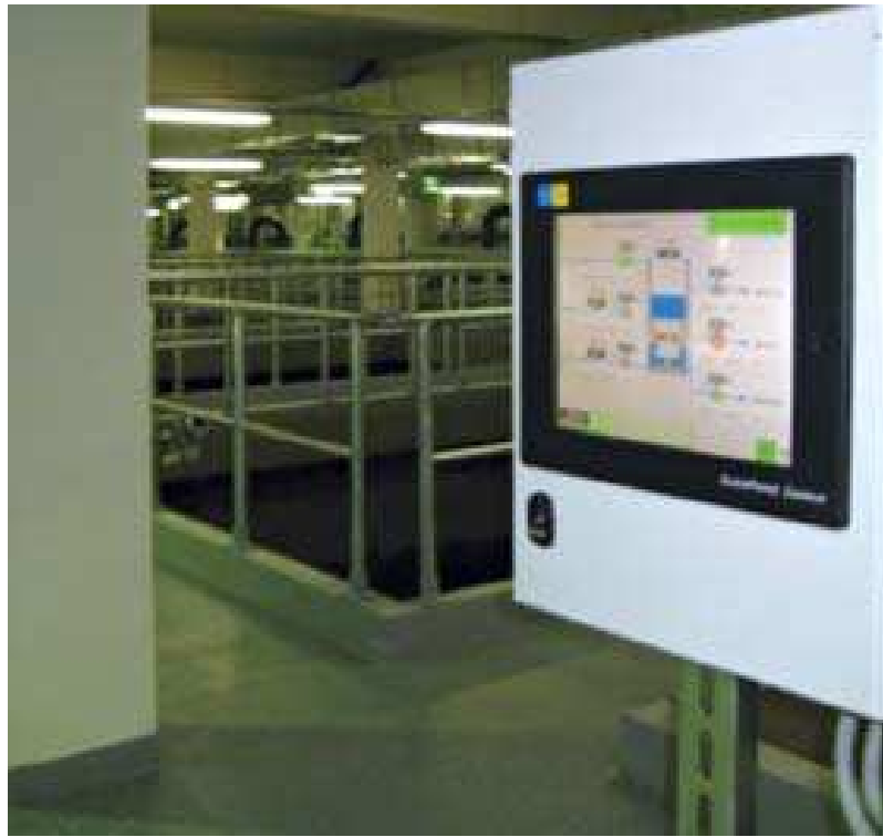
圖四 過濾器操作管理面板
