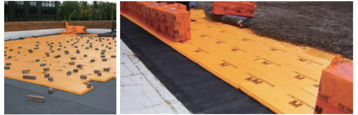
Фото. Инверсионная эксплуатируемая кровля, объект Балтийская жемчужина, Санкт-Петербург （照片）倒置式上人屋面，聖彼得堡《波羅地海珍珠》工程項目
