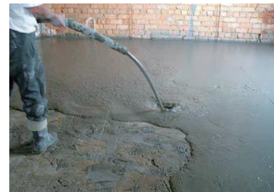
圖三、以一體澆注泡沫混凝土施作隔熱層
