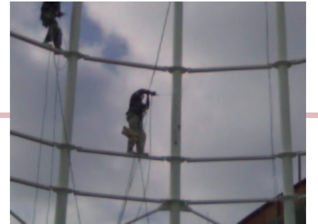
工人於建築鋼構上噴灑防火石膏塗料照片
